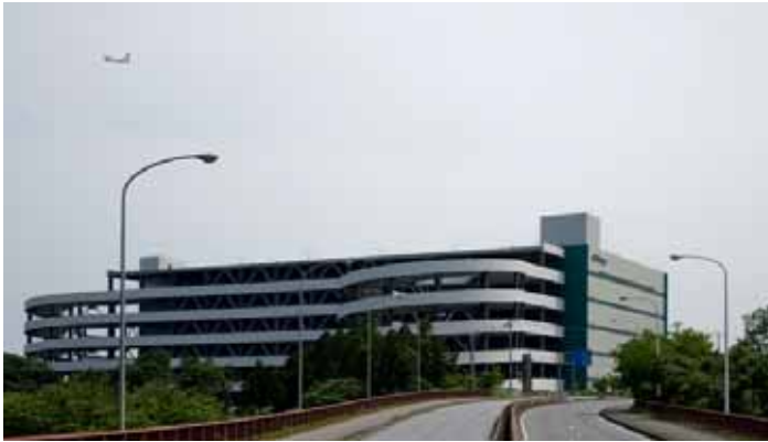
プロロジスパーク成田 成田空港側より撮影
