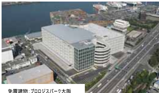
免震建物：プロロジスパーク大阪
