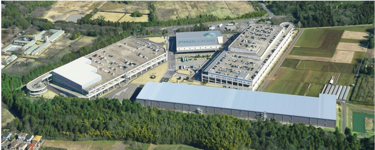
「プロロジスパーク成田 1」全体像(敷地内手前の施設が「プロロジパーク成田 1-D」)
