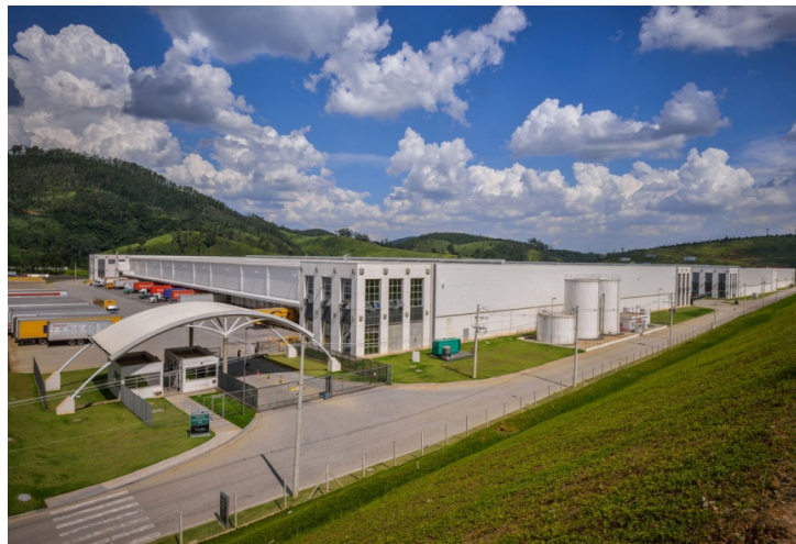
プロロジス CCP カハマル I 物流パーク
