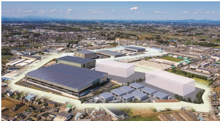
プロロジス古河プロジェクト フェーズ1・フェーズ2 全景
