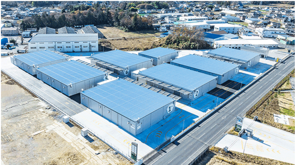
HAZMAT 倉庫 8 棟からなる物流施設「プロロジスパーク古河 6」 建設段階（A1-A5）の LCA 算定結果で 17%の温室効果ガス排出量削減を達成した
